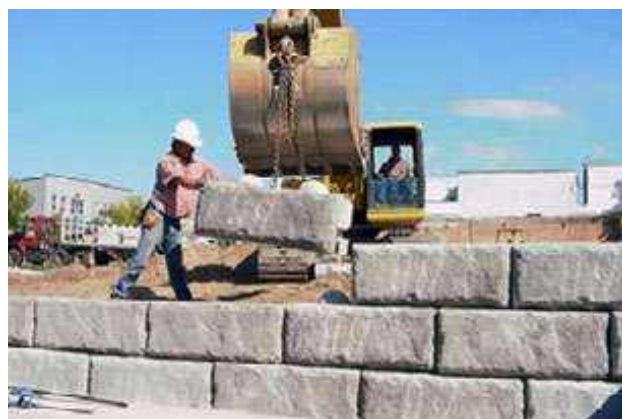
Рисунок 10а Монтаж блоков
